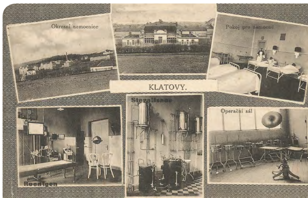
Dobová pohlednice s interiéry nemocnice, 30. léta
